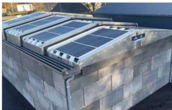
Panneaux solaires souples collés sur les panneaux de toiture.
