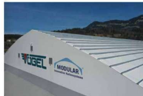
Rails installés sur une toiture métallo-textile pour recevoir les panneaux solaires et équipements annexes.
