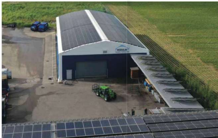
Bâtiment de 20x40 m accueillant 800 m 2 de panneaux solaires.
