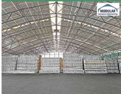
Les panneaux sont disposés de manière à garantir un éclairage naturel satisfaisant.
